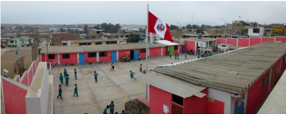
Foto 03: Vista del patio central de la I.E. que está en regular estado de conservación, pero no logra brindar un adecuado espacio para los distintos niveles educativos.
